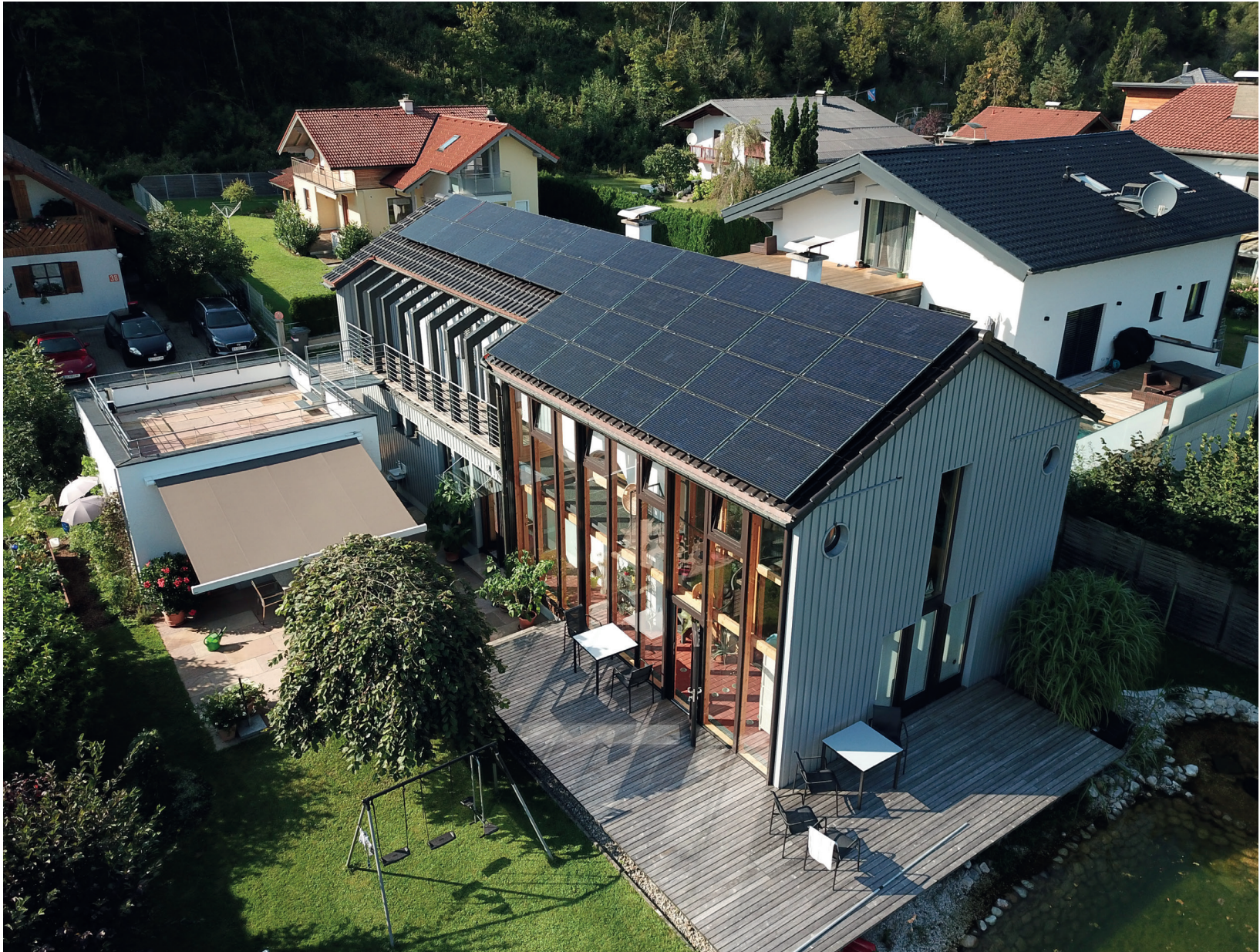
Unsere 9,3-kWh-PV-Anlage mit einer Sonnenschein-Tagesleistung von 60 kWh lädt den ID.Buzz / Bild rechte Seite: Anzeige im ID.Buzz
